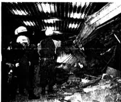
倒壊したビルの中での作業
