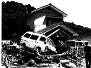
被災した新宮警察署井関駐在所
