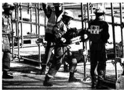
▲エンジンカッターでの切断
