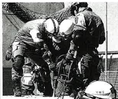
コンクリートをドリルで砕く
