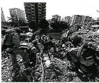
コンクリート掘削(写真提供JICA)
